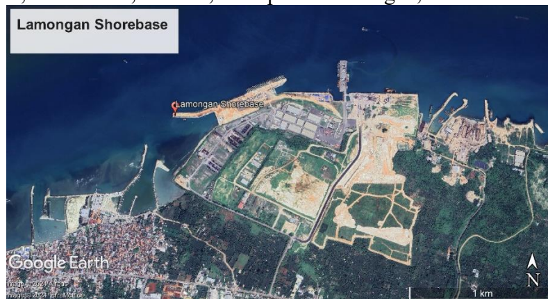
Gambar 1.1 Lokasi Proyek Pembangunan Breakwater di Lamongan Shorebase (Sumber : Google Earth, 2024)
