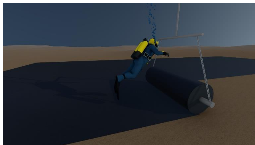
Gambar 7.12 Penggelaran Geotextile Woven (2)
