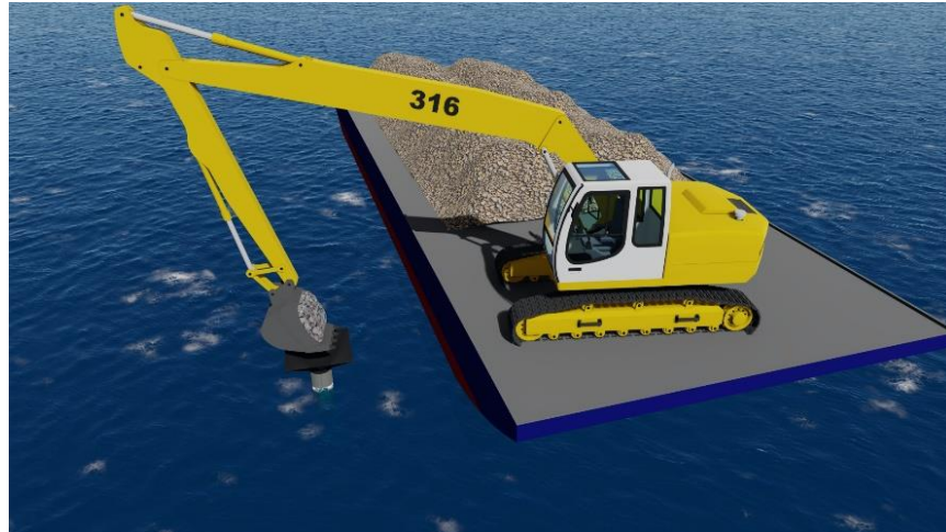
Gambar 7.5 Penuangan Material Pengisi Pada GESC
