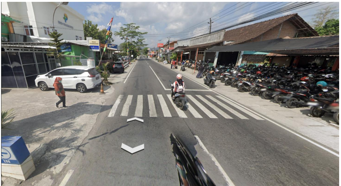
Gambar 5. 13 Gambar Lapangan STA 6-7 Prambanan-Piyungan
