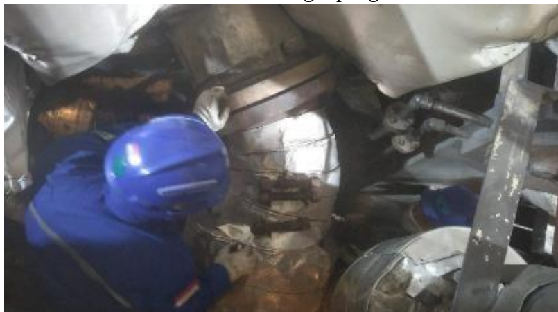
Gambar 4. 29 penggantian mur baut pengikat, washer dan SWG Flange RCA No.1,2,3
