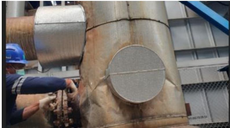
Gambar 4. 28 Pengantian mur baut di SWG Flange RCA sisi in dan out
