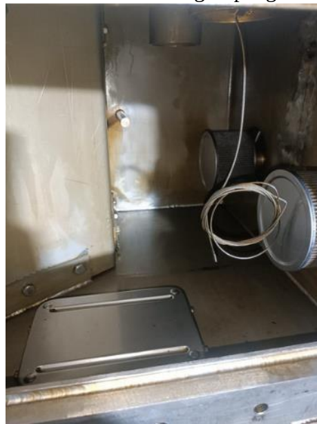
Gambar 4. 37 Kondisi setelah melakukan Cleaning & inlet strainer
