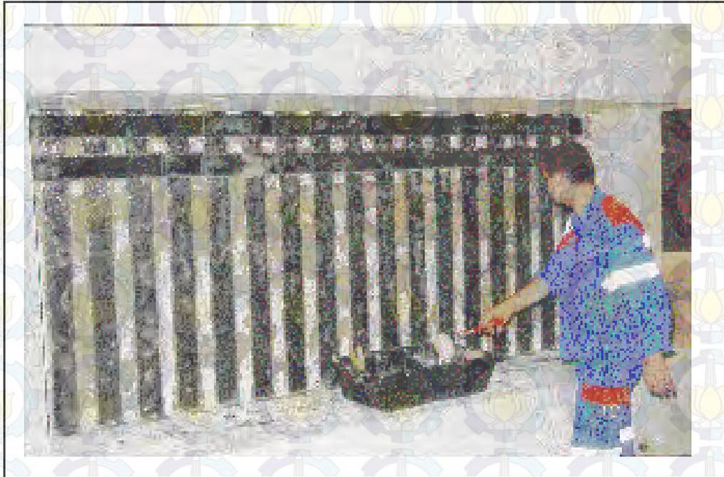
Figure 3.3 Pose des matériaux composites sur le mur T13 (URGC, 1999)
