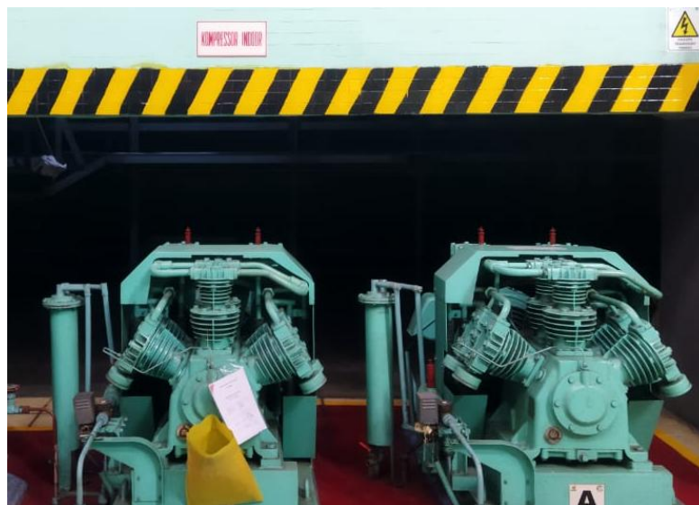
Gambar 4.15 Kompresor Indoor (Sumber: Dokumen Penulis, 2025)
