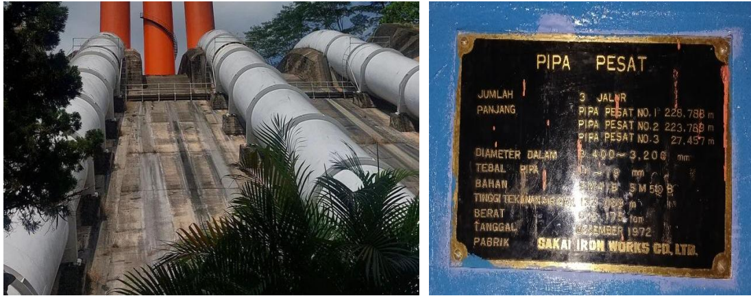
Gambar 4.6 Penstock (kanan) dan Spesifikasi Penstock (kiri)
