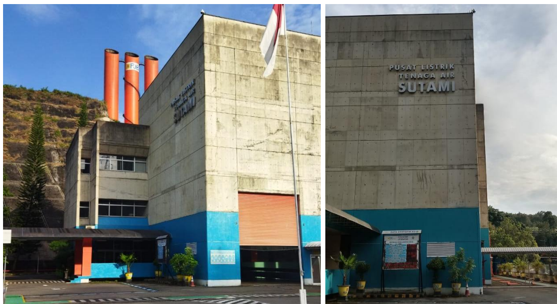
Gambar 2.4 Bangunan PLTA Sutami Tampak Halaman Depan (Sumber: Dokumen Penulis, 2025)
