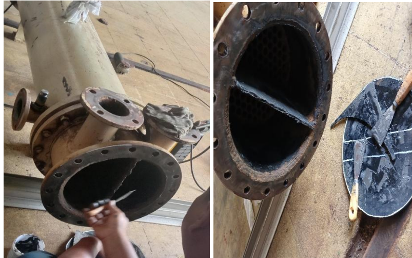
Gambar 4.24 Cooler yang sedang di Coating
