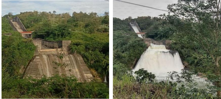
Gambar 4.2 Spillway Kondisi Air Waduk Normal (Kiri) Kondisi Banjir di Waduk (Kanan) (Sumber: Dokumen Penulis, 2025)
