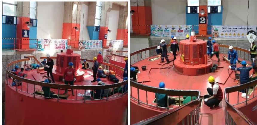
Gambar 4.25 Pembersihan Radiator Generator 1, 2, dan 3
