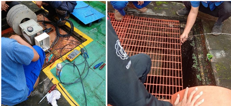
Gambar 4.28 Proses Penggantian Level Transmitter bersama Teknikal Listrik (Sumber: Dokumen Penulis, 2025)
