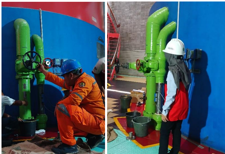
Gambar 4.23 Proses Pengosongan Air Sisa Pendinginan di Radiator (Sumber: Dokumen Penulis, 2025)
