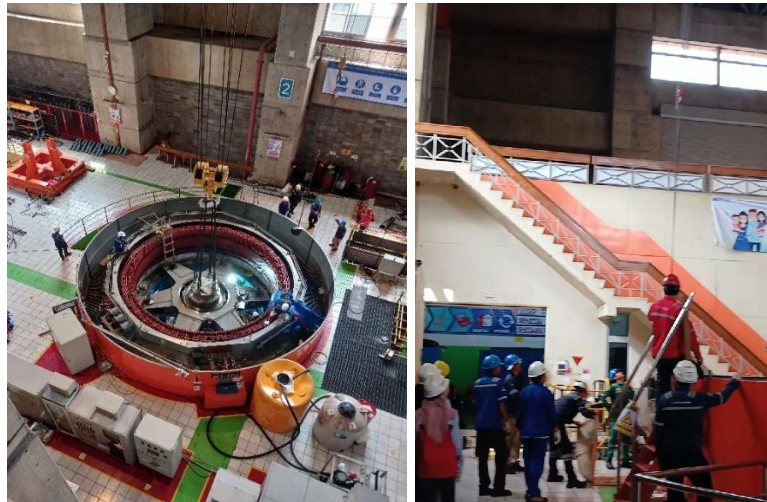
Gambar 4.39 Kegiatan Proses Pembongkaran Total Generator (Sumber: Dokumen Penulis, 2025)
