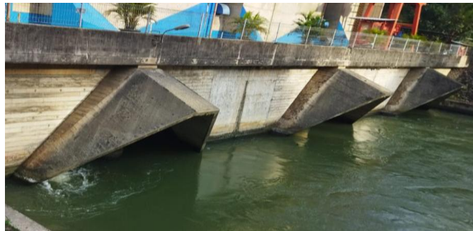
Gambar 4.4 Saluran Bawah ( Tail Race )
