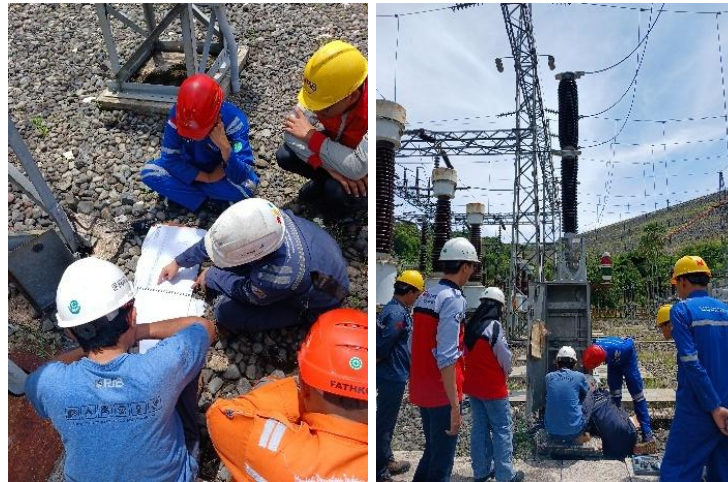
Gambar 4.26 Pengecekan Sambungan Circuit Breaker oleh Teknikal Listrik (Sumber: Dokumen Penulis, 2025)
