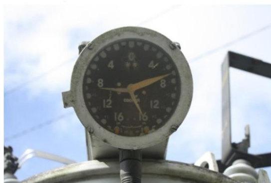
Gambar 2. 16 Indikator Posisi Tap SVR
