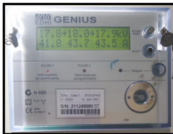
Gambar 1. 2 Tegangan Penyulang Cartenz di GH Prafi Pada KWH Meter AMR
