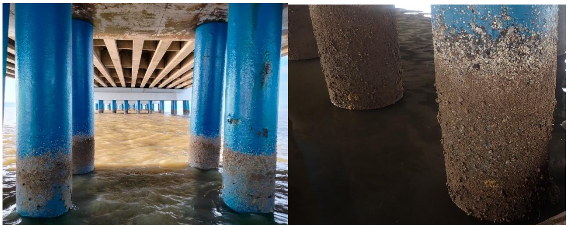
Gambar 6.2. Tiang Pancang Jembatan Suramadu sisi Surabaya di Zona Terendam
