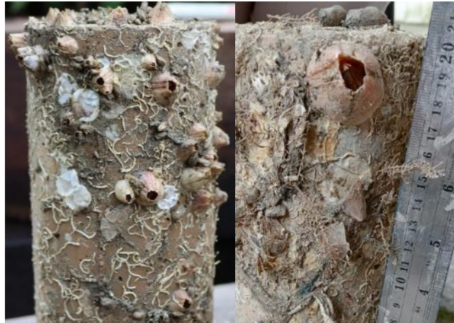
Gambar 1. 2. Sampel beton yang ditumbuhi teritip pada 5 bulan perendaman di zona terendam pada Perairan Kenjeran, Surabaya (Ekaputri dkk, 2022)
