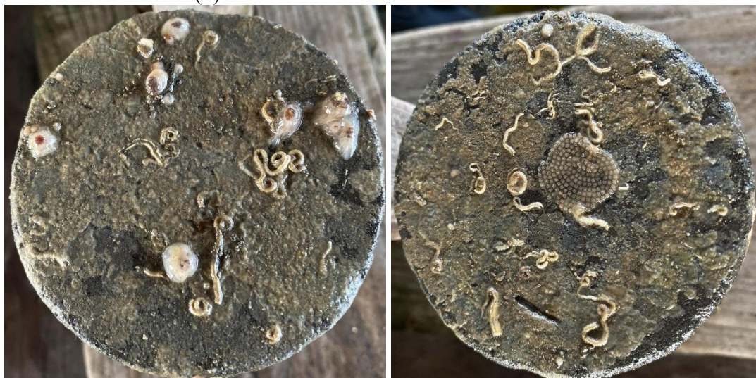
(c) Zona Terendam Beton Konvensional yang Dilapisi Mortar Geopolimer
