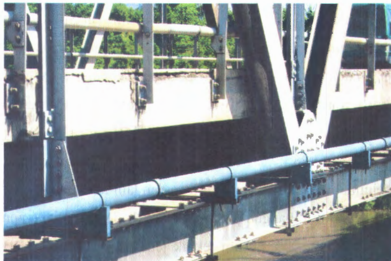
Gambar 4.5 Kondisi Jembatan Sabrang (Sumber : Hasil observasi lapangan, 2009)
