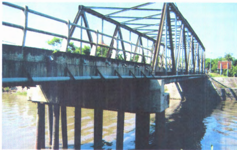
Gambar 4.3 Jembatan Sabrang (Sumber : Hasil observasi lapangan, 2009)
