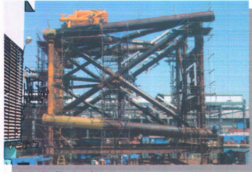
Gambar 1.1 Pengelasan pada tubular joint jacket WHP-A Amerada Hess Indonesia Pangkah (PT PAL, 2006)
