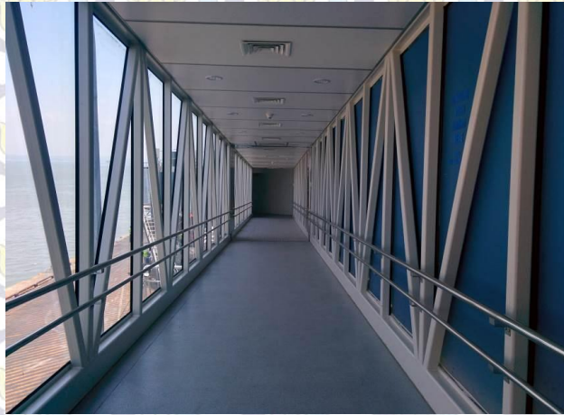
Gambar 4.30 Fasilitas Garbarata yang digunakan untuk menaiki kapal.
