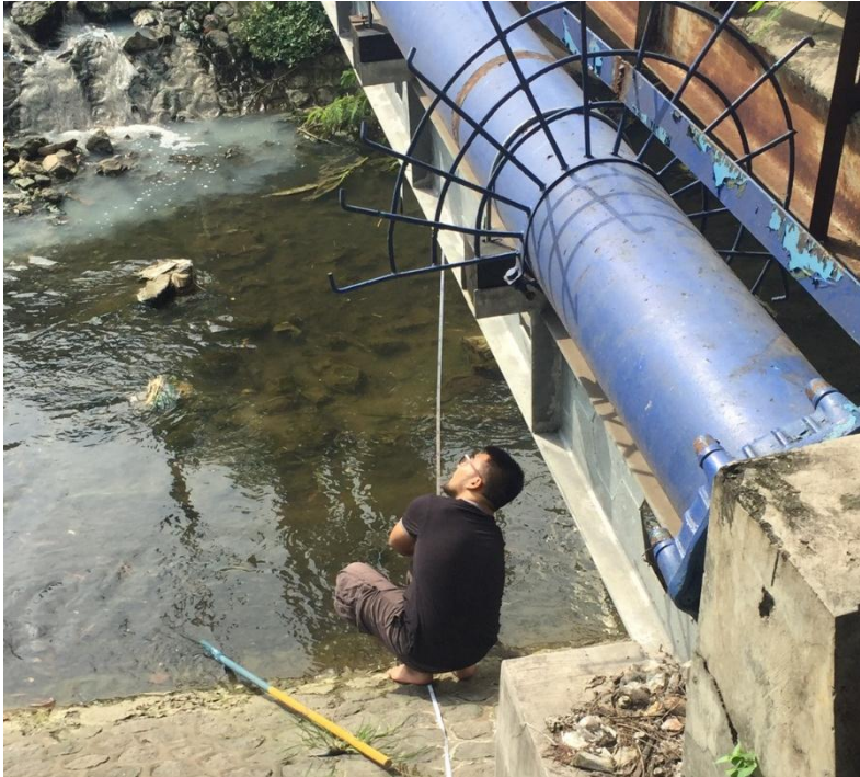
Lampiran Gambar 7 Foto Pengukuran Penampang Saluran Lidah Kulon (Sumber: Dokumen Pribadi)
