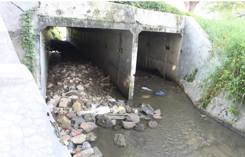
Lampiran Gambar 2 Foto Penampang Saluran Pembuang Kolam Tampung Pakuwon
