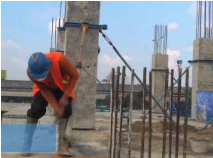
Gambar 10.1 Pemasangan Bracing pada Kolom
