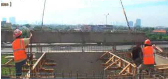
Gambar 10.2 Pemasangan Balok Induk Pracetak
