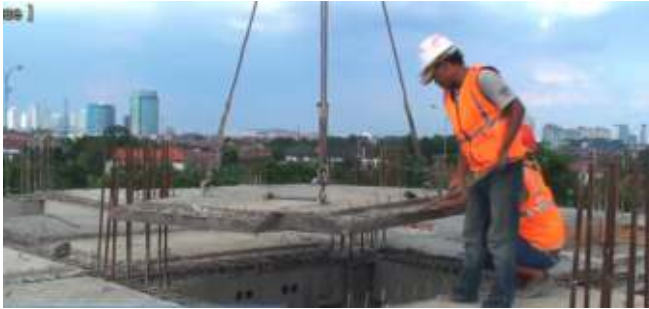
Gambar 10.4 Pemasangan Pelat Pracetak
