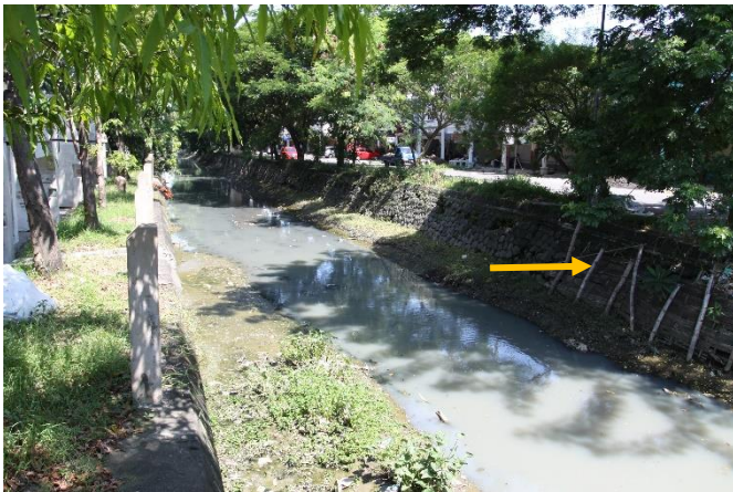
Gambar 4. 1. Penampang Saluran yang Kurang Layak (Saluran Primer)
