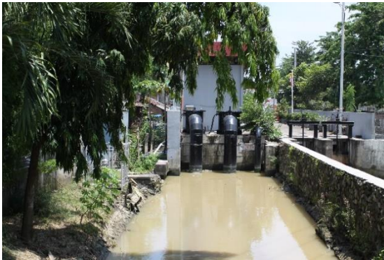
Gambar 4. 11 Rumah Pompa Jambangan (Sumber : Dokumen Pribadi)
