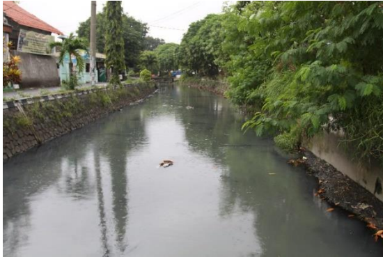
Gambar 4. 4 Pemukiman di Tepi Saluran Primer Kebon Agung - Jemur
