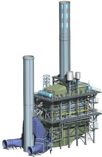
Gambar 1.1 HRSG tipe vertikal[1]
