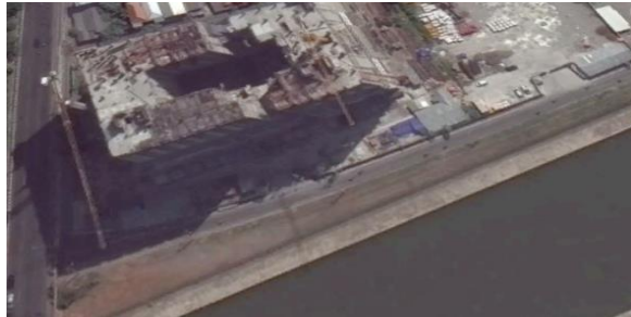
Gambar 1.7 Ruas Jalan Medokan Semampir Indah (Depan Bangunan Studi)
