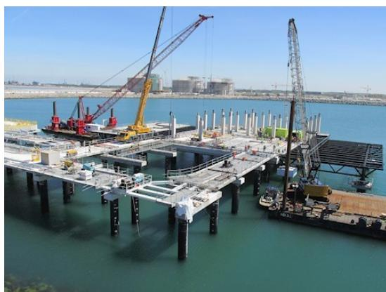
Gambar 6.9 Pekerjaan Pemasangan Komponen Pracetak pada Struktur Jetty
