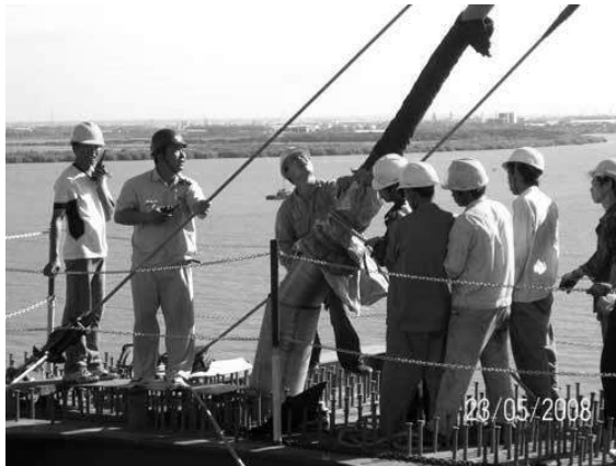
Gambar 2.40 Pengangkutan kabel pada dek jembatan Suramadu berupa angkur mati ( www.wiryanto.net )
