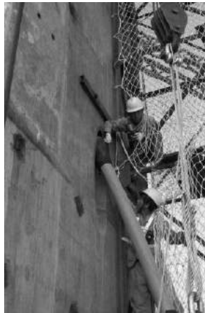
Gambar 2.36 Pengangkuran kabel pada pylon jembatan Suramadu ( www.wiryanto.net )
