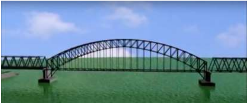
Gambar 2. 25 Setelah Pembongkaran Temporary Cabel dan Temporary Tower
