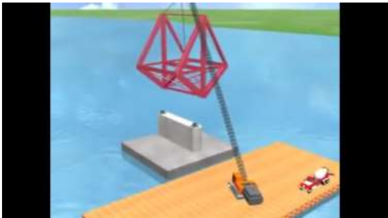
Gambar 2. 18 Pemasangan Portal Awal dan Akhir
