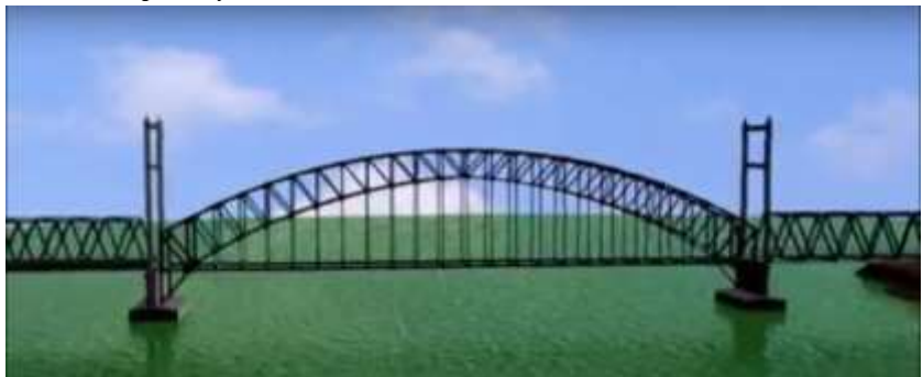
Gambar 2. 24 Pembongkaran Temporary Cabel dan Temporary Tower
