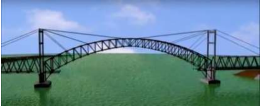
Gambar 2. 21 Pemasangan Segmen tengah dibantu dengan Temporary Cabel
