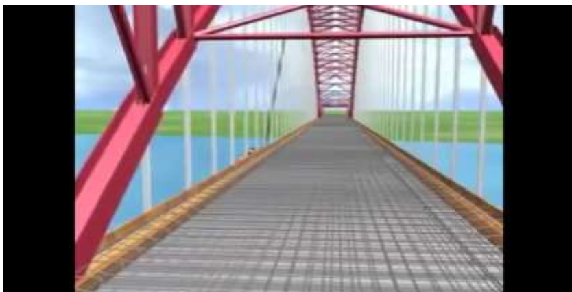
Gambar 2. 27 Pemasangan Pembesian lantai Kendaraan
