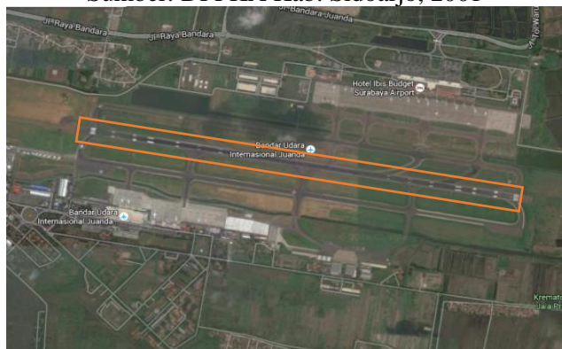
Gambar 1. 2 Lokasi Runway Bandar Udara Juanda
