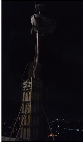
Gambar 4. 95 Penuangan Beton pada Bekisting Kolom
