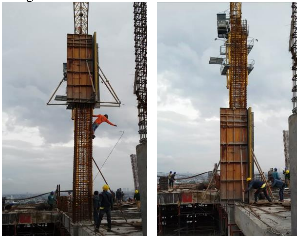
Gambar 4. 90 Pemasangan Bekisting Kolom
