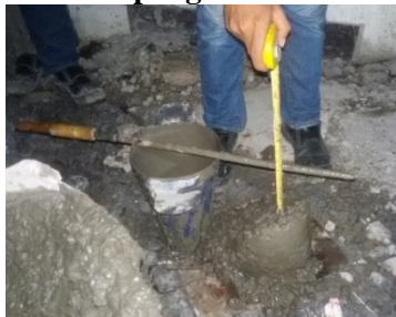
Gambar 4. 93 Slump Test di Lapangan
