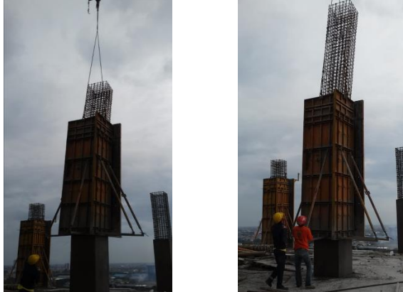
Gambar 4. 97 Pembongkaran Bekisting Kolom
