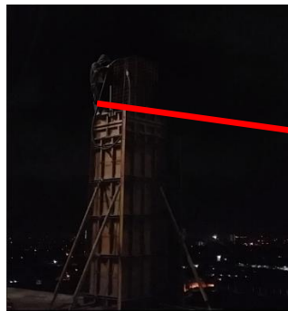
Gambar 4. 96 Pepadatan Beton Kolom dengan Vibrator
