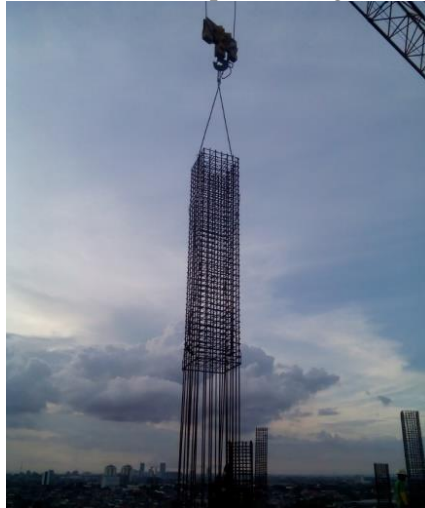
Gambar 4. 83 Pengangkatan Tulangan Kolom dengan Tower Crane
