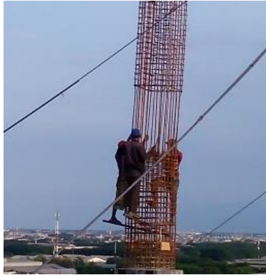
Gambar 4. 85 Penyambungan Tulangan Kolom
