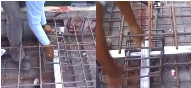
Gambar 4.131. Pemasangan Tulangan Angkur
