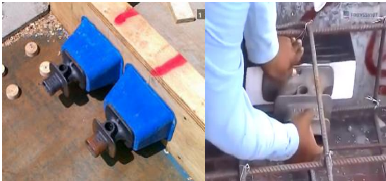
Gambar 4.128. Pemasangan Angkur Aktif pada bekisting
