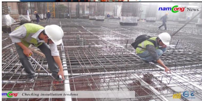
Gambar 4.132. Persiapan Sebelum Pengecoran Pelat Lantai Prategang
