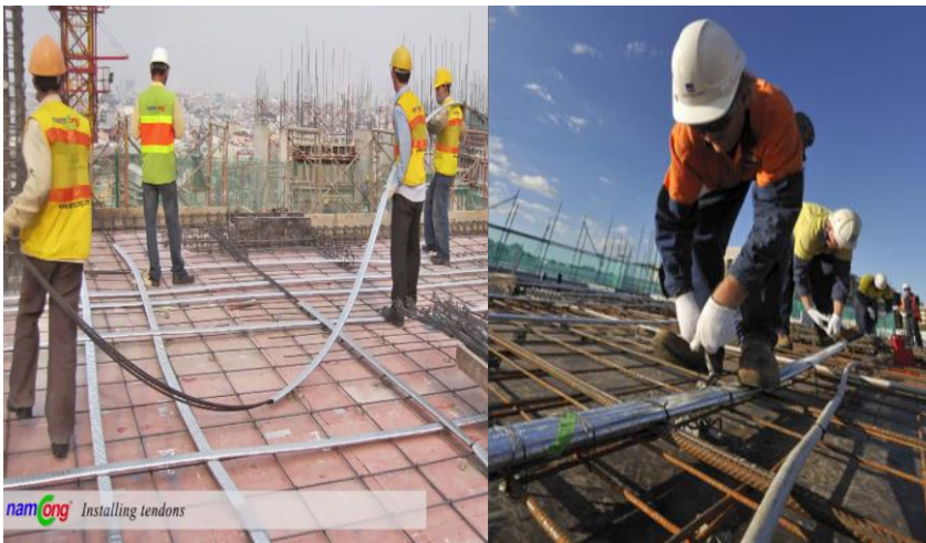
Gambar 4.126. Proses Instalasi dan Pemasangan Tendon
