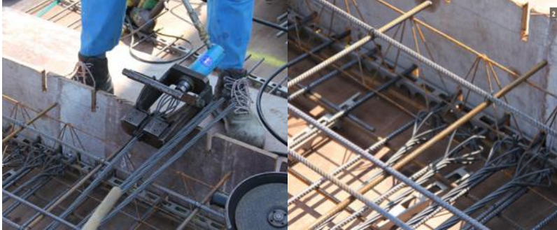
Gambar 4.129. Perakitan dan Pemasangan Angkur Pasif
