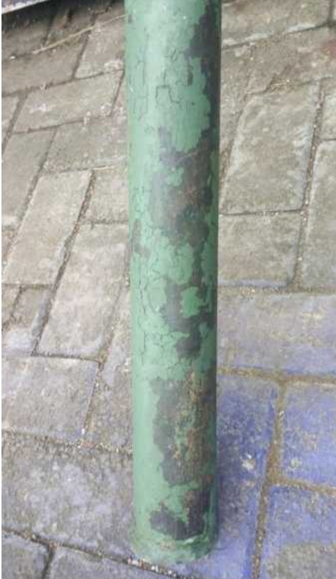
Gambar 4.7 Permukaan pipa coating primer setelah 28 hari
