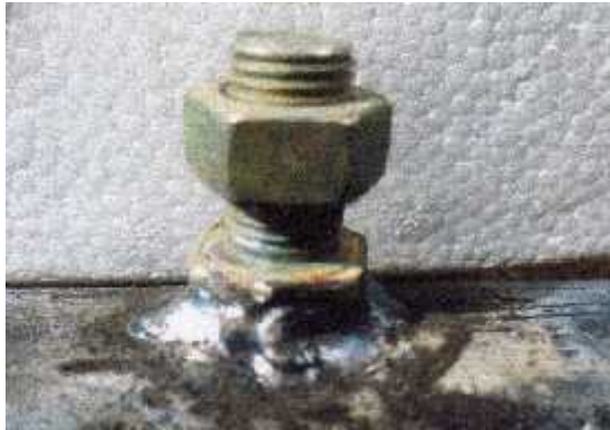
Gambar 3.10 Pengait kabel pada pipa baja
