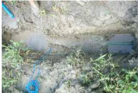
Gambar 3.18 Pipa ditanam di kedalaman 50 cm
