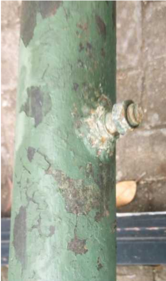
Gambar 4.9 Sambungan lasan pada pipa coating primer
