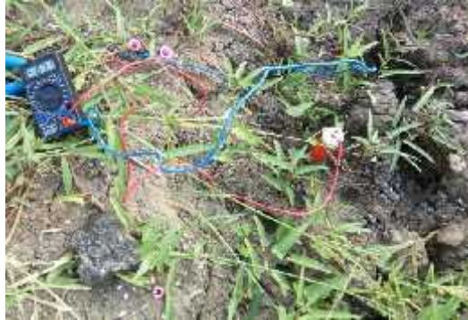
Gambar 3.20 Pengukuran tegangan proteksi
