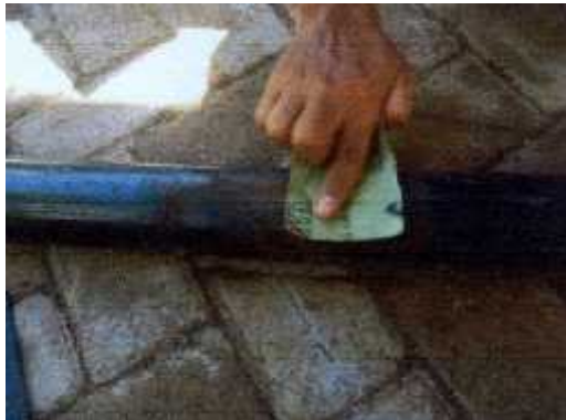
Gambar 3.9 Pembersih Pipa dari pengotor
