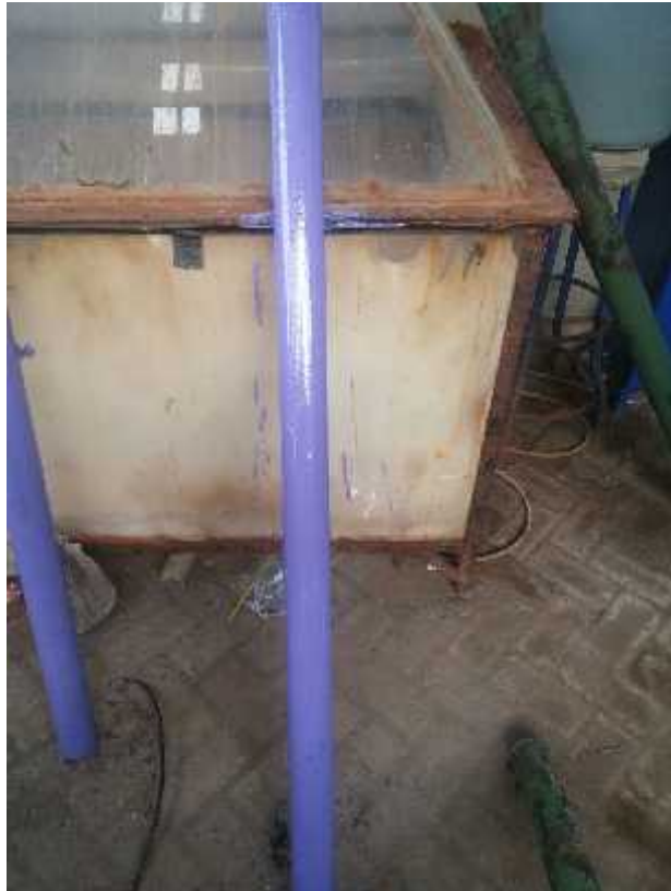
Gambar 3.12 Pemberian Coating Ganda (Primer dan Sekunder)
