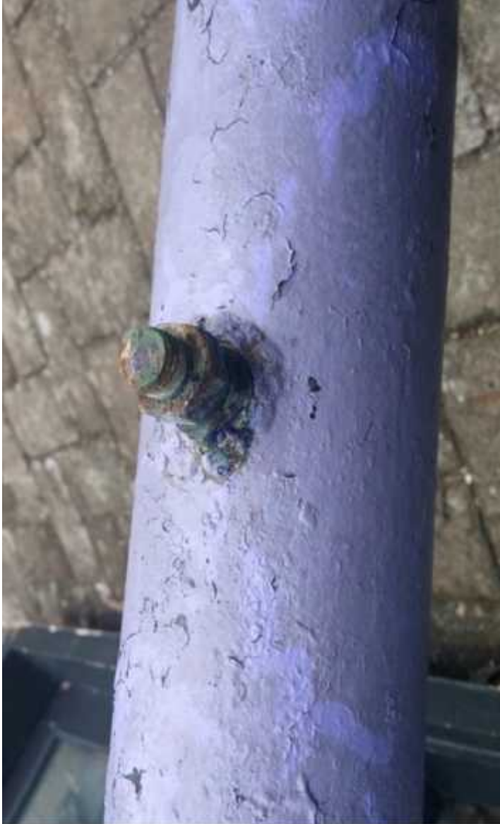
Gambar 4.10 Sambungan lasan pada pipa coating primer dan sekunder
