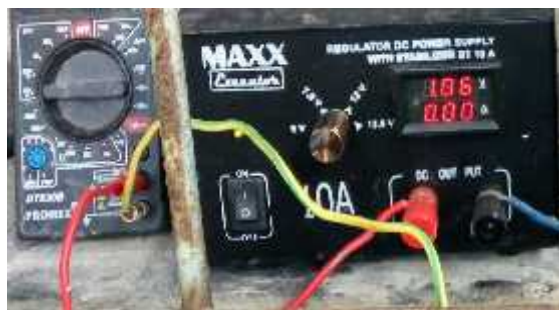
Gambar 3.17 Instalasi sambungan kabel pada Rectifier
