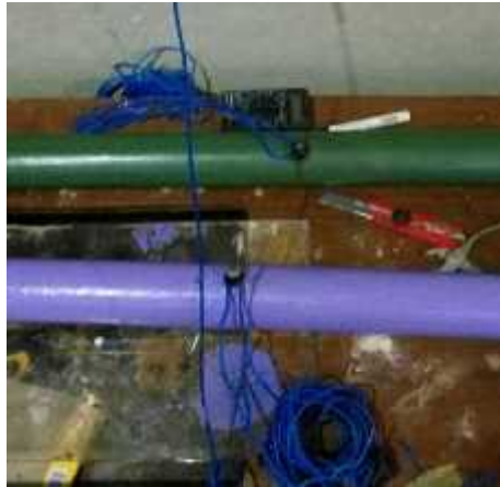
Gambar 3.16 Pemberian kabel pada pipa
