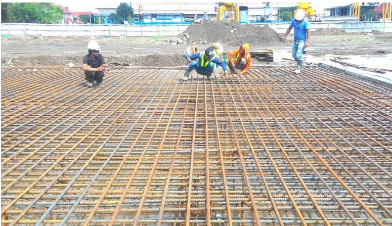
Gambar 4.3.1 pekerjaan penulangan Pelat
