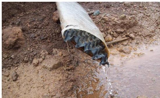
**Gambar 2.16** Air pori dari PVD yang disalurkan ke PHD untuk menuju saluran drainase disamping kanan/kiri timbunan
