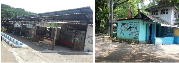
Gambar IV. 10 Lokasi pengolahan ikan di Sine Desa Kalibatur (kiri) dan pengolahan ikan Popoh desa Besole (kanan)
