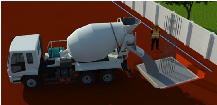
Gambar 10. 17 Pengecoran Pilecap
