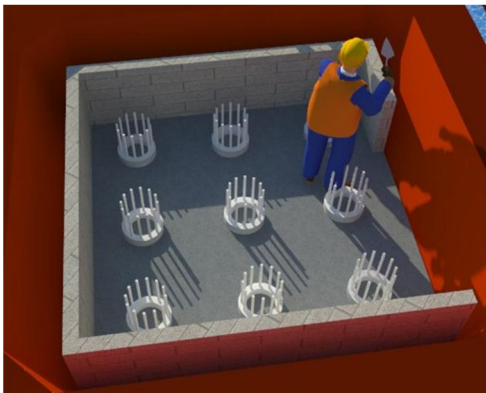
Gambar 10. 15 Pemasangan Bekisting Pilecap
