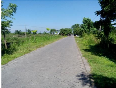
Gambar 4.10 Kondisi jalan paving di Desa Pandeg, Kecamatan Cerme
