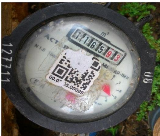
**Gambar 5. 4 Contoh Temuan Meter Air pada Rumah Tangga yang Telah Menggunakan Pembacaan *Barcode***
