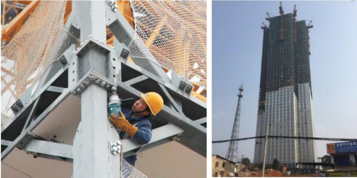
Gambar 2.5. Proses perakitan sistem lantai integral di lapangan (kiri) dan contoh implementasi teknologi BSB pada gedung 57 lantai J57 di Tiongkok (kanan)
