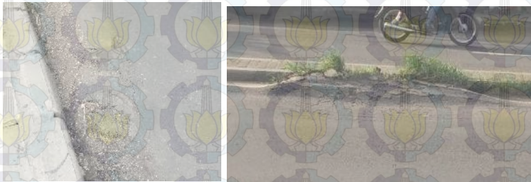
Gambar 4. 3. Alur (113) pada STA 7+154 dan STA 0+335
