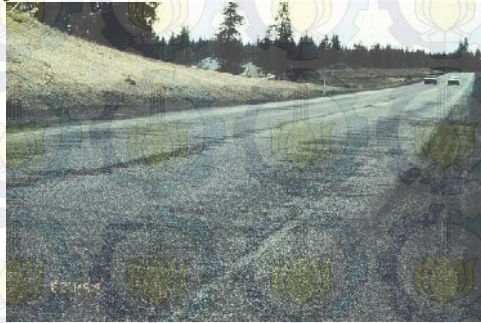
Gambar 2. 15 Pelepasan butir (raveling)
