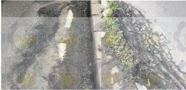
Gambar 4. 5. Jembul (115) pada STA 1+623 dan 3+155
