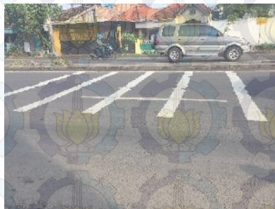
Gambar 4. 17. Marka jalan salah (532) pada STA 3+579
