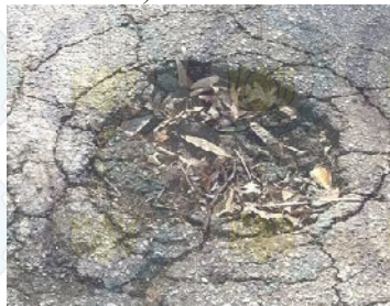
Gambar 2. 14 Jembul (upheaval)
