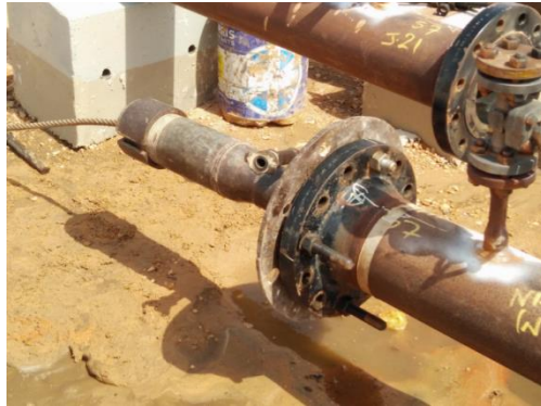
Gambar II.6. Penutup pipa besi dipasang. (dokumentasi pribadi; Oman,2016)
