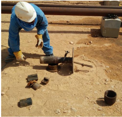
Gambar II.3. Menyiapkan penutup pipa besi. (dokumentasi pribadi; Oman,2016)
