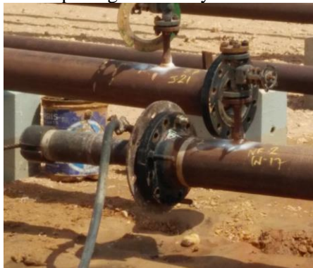
Gambar II.7. Udara bertekanan dimasukkan. (dokumentasi pribadi; Oman,2016)
