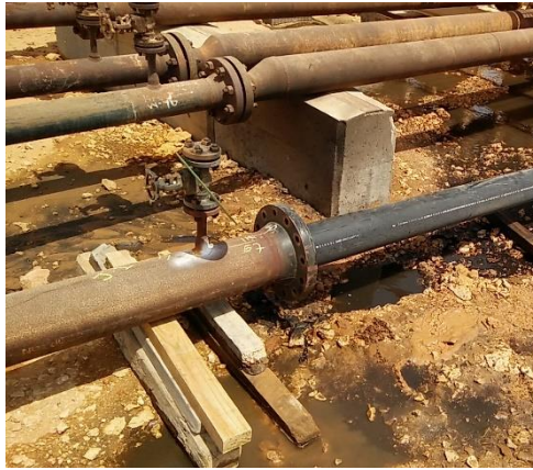
Gambar II.9. HDPE Liner ditarik ke dalam pipa besi. (dokumentasi pribadi; Oman,2016)
