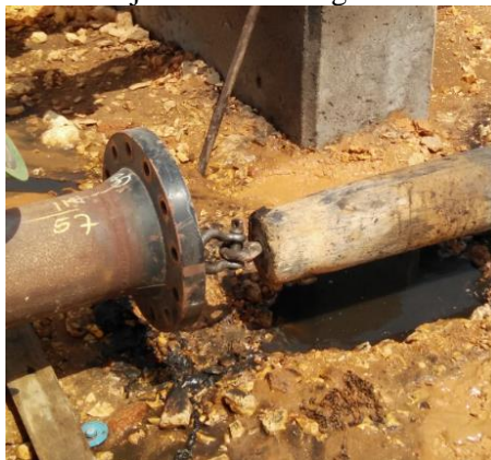
Gambar II.8. Katikan tali baja dengan HDPE Liner . (dokumentasi pribadi; Oman,2016)
