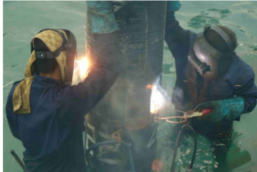
Gambar 6. 5 Pemotongan Tiang Pancang
