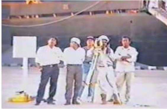
Gambar 6. 3 Cek Titik Tiang Pancang Dari Darat Dengan Theodolit
