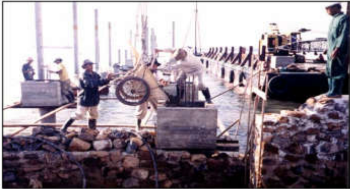
Gambar 6. 8 Pengecoran Insitu Poer
