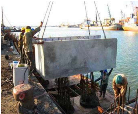
Gambar 6. 7 Pemasangan Bekisting
