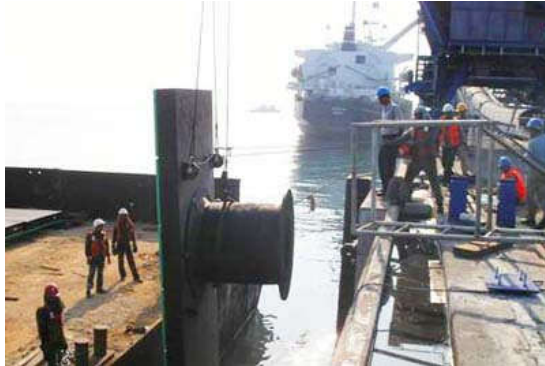
Gambar 6. 12 Penempatan Posisi Fender
