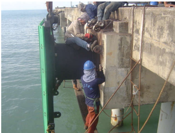
Gambar 6. 13 Pemasangan Angker Pada Fender
