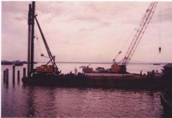
Gambar 6. 1 Ponton Pancang dan Ponton Crane
