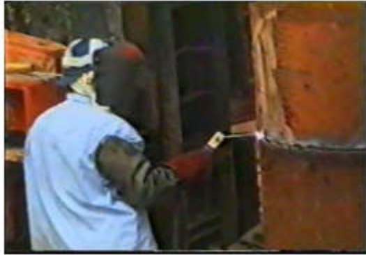
Gambar 6. 4 Penyambungan Tiang Pancang
