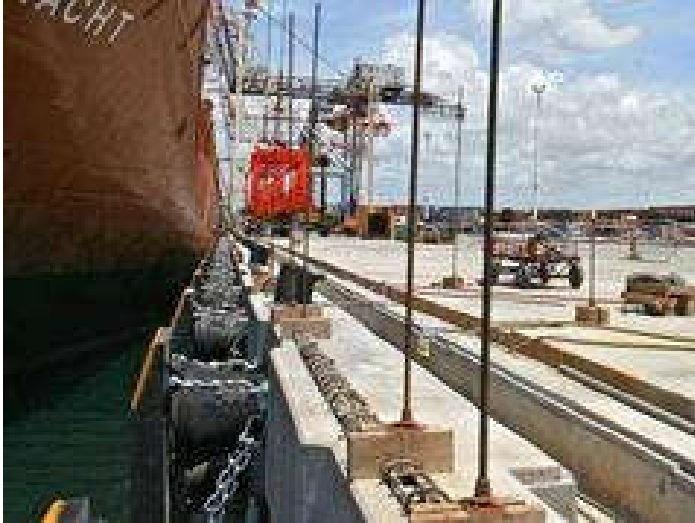
Gambar 6. 14 Pemasangan Rel Crane
