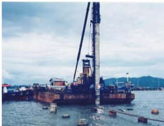
Gambar 6. 2 Pemancangan Tiang Pancang
