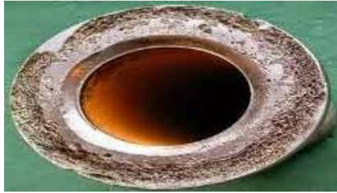
Gambar 2.13 korosi celah pada sambungan pipa
