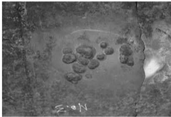
Gambar 2.17 korosi Biologis pada Pipa
