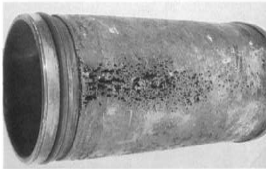
Gambar 2.15 korosi erosi pada pipa
