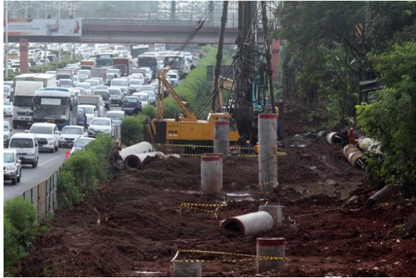
Gambar 7. 5 Pemancangan spun pile
