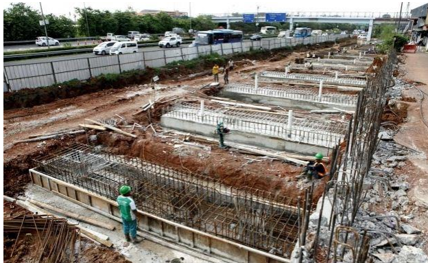
Gambar 7. 7 Pemasangan bekisting dan penulangan
