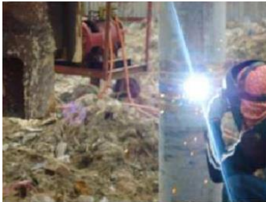
Gambar 7. 6 Pengelasan sambungan tiang
