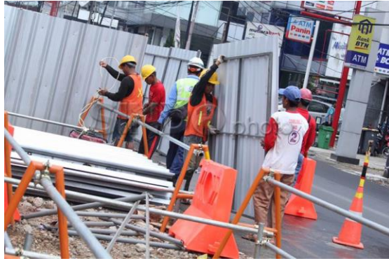
Gambar 7. 2 Pemasangan pagar pembatas proyek
