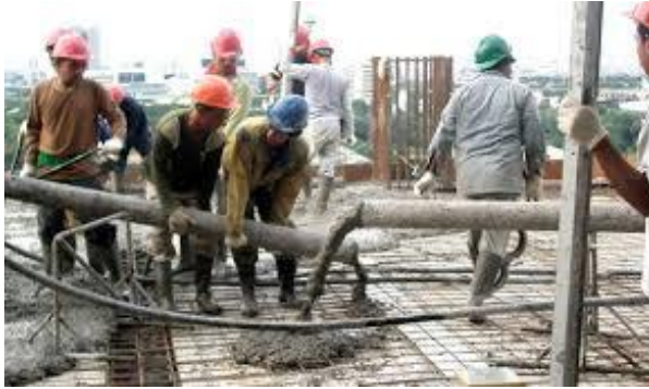
Gambar 7. 8 pekerjaan pengecoran pelat dan dinding
