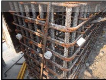
Gambar 6. 6 Decking Beton pada Shearwall
