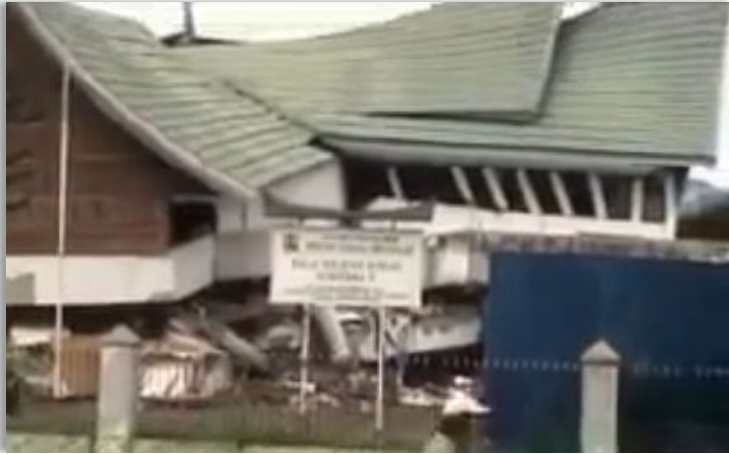
Gambar 1.1. Gedung runtuh setelah kejadian gempa Padang (2009) ( Photo by Windra )
