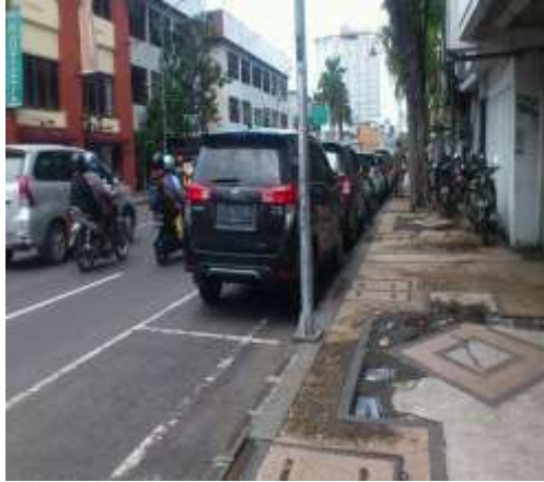
Gambar 4.11 Trotoar Jalan Tunjungan Sisi Kanan (Sumber : Dokumentasi Pribadi ,2017)
