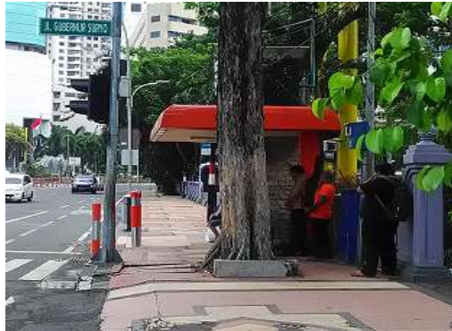
Gambar 4.14 Trotoar Jalan Gubernur Suryo Sisi Kiri
