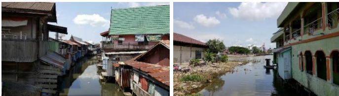
Gambar 4.1 Pemukiman di Sepanjang Bantaran Sungai Guring dan Kondisi Saluran yang Kurang Terawat
