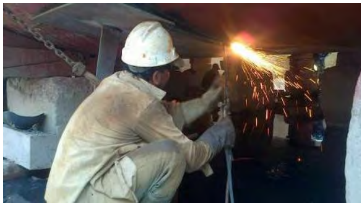
Gambar 1.1 Pengelasan Pelat Pada Proses Replating
