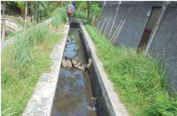
Gambar IV.2. Pengambilan Air Liar dan Pembendungan di Saluran
