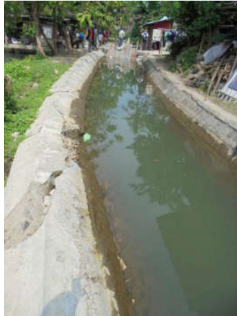
Gambar II.3. Kondisi Saluran Primer
