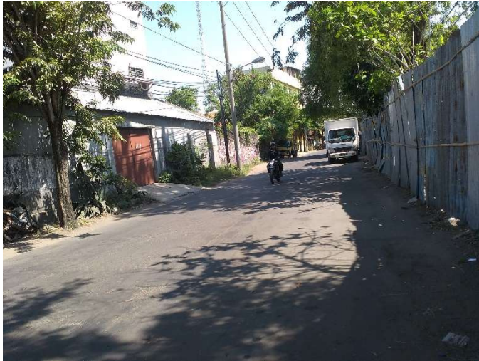
Gambar 4.11. Kondisi Geometrik Simpang C Pendekat Barat (Jl. Johar)
