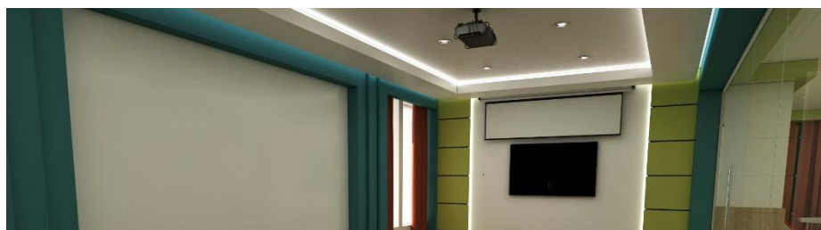
Gambar 4.45 Plafon pada ruang meeting Sumber : Dokumentasi Penulis (2017)
