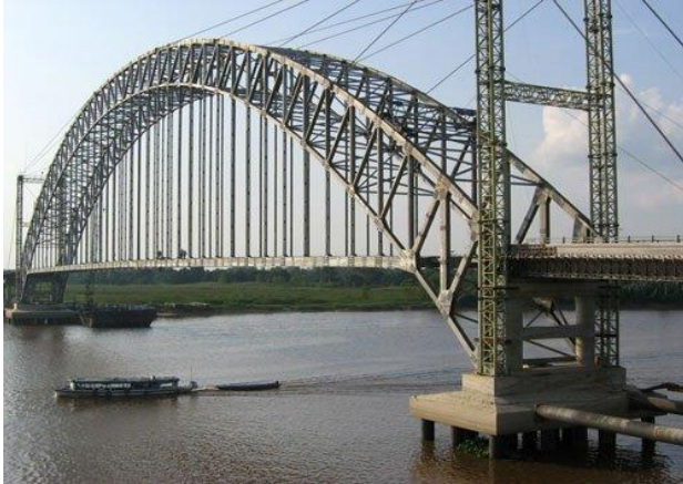
Gambar 2.5 Jembatan Martadipura dalam masa pembangunan
