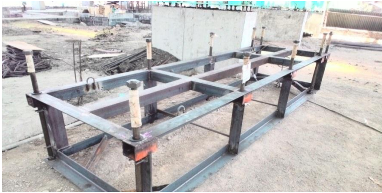
Gambar 4.9 Pembuatan Anchor Yang Telah Mengalami Perubahan Desain
