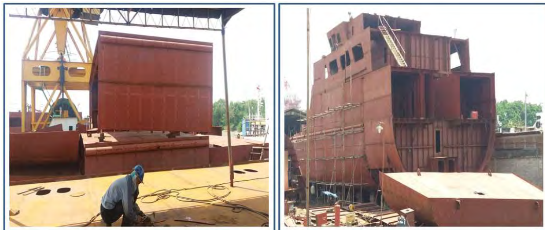
Gambar 2.10. Pekerjaan erection di galangan no 24.
