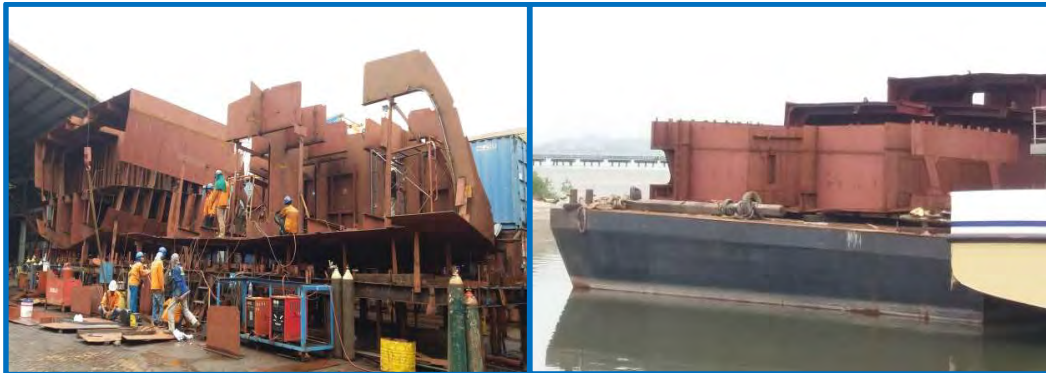
Gambar 2.9. Tahapan Assembly dan Penumpukan blok di tongkang
