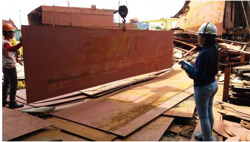
Gambar 2.5 Pemindahan Material Sebelum di cutting
