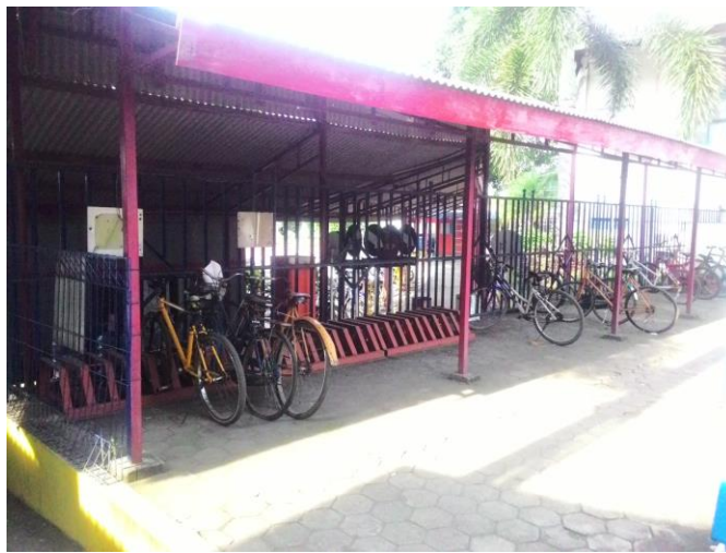
Gambar 1.1 Shelter A di sisi utara bangunan PT. INKA
