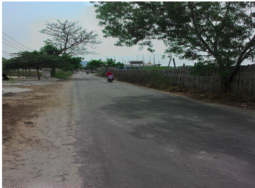
Gambar V.5 Akses Jalan Lokasi Panceng
