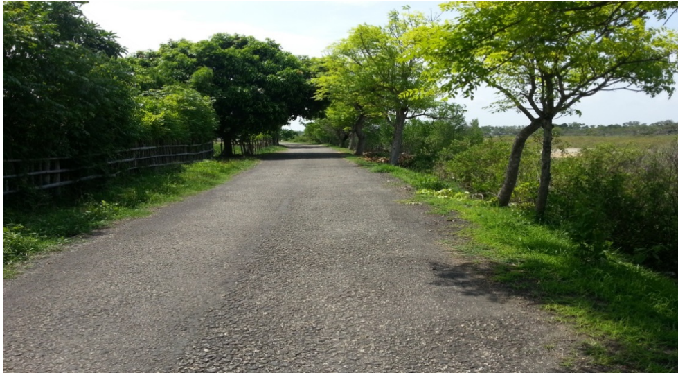
Gambar V.3 Akses Jalan Lokasi Madura
