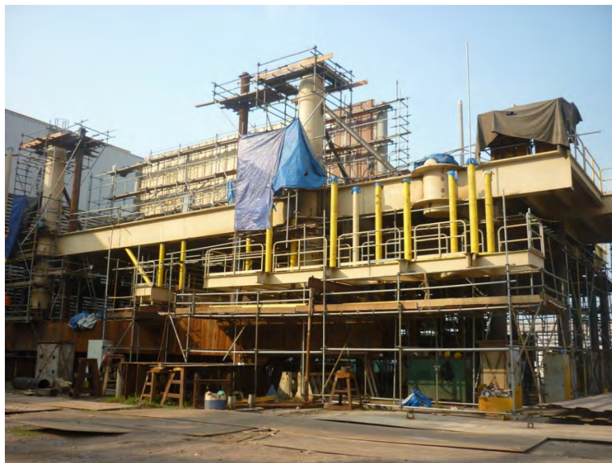
Gambar II.5 Proses Pembangunan Topside Deck (Sumber : PT. PAL Indonesia)
