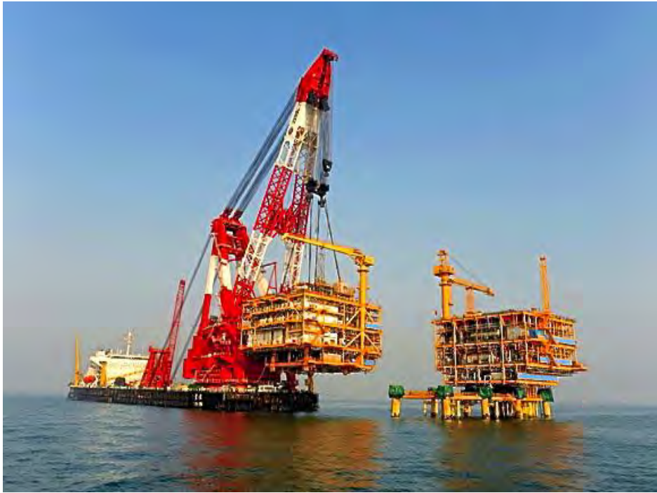
Gambar 2. Contoh Proses Decommissioning pada sebuah Offshore Platform
