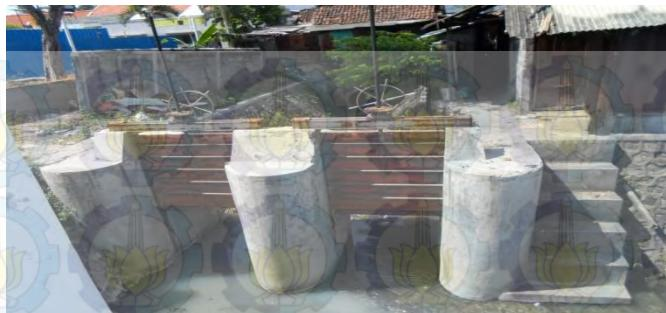
Gambar 5:Saluran Harun T Rusak dan Tertutup Tanah
