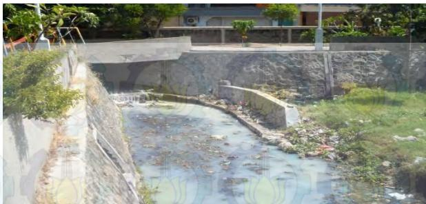
Gambar 1 :Saluran Sumur Songo Terjadi Pengendapan tanah
